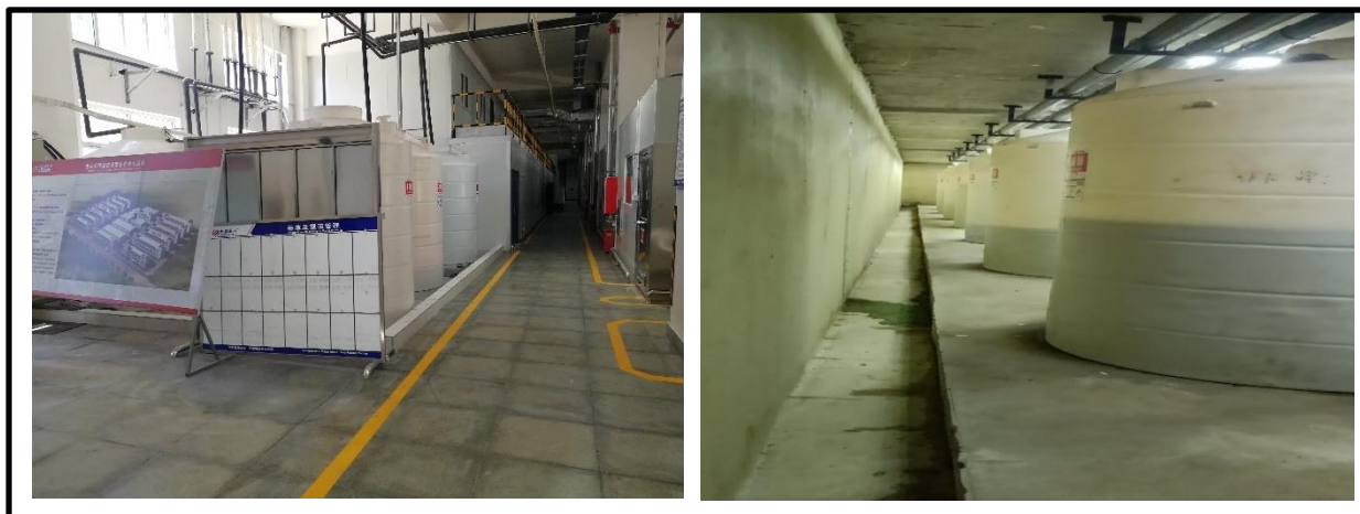
图 4-5 A2、B3 废水收集区防渗措施
