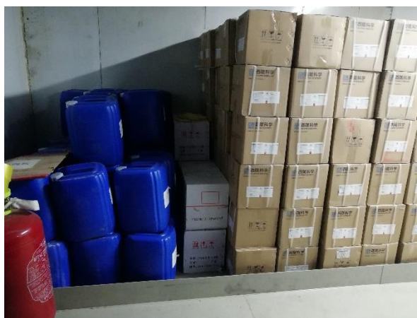
A2 液体化学品库设置的围堰
