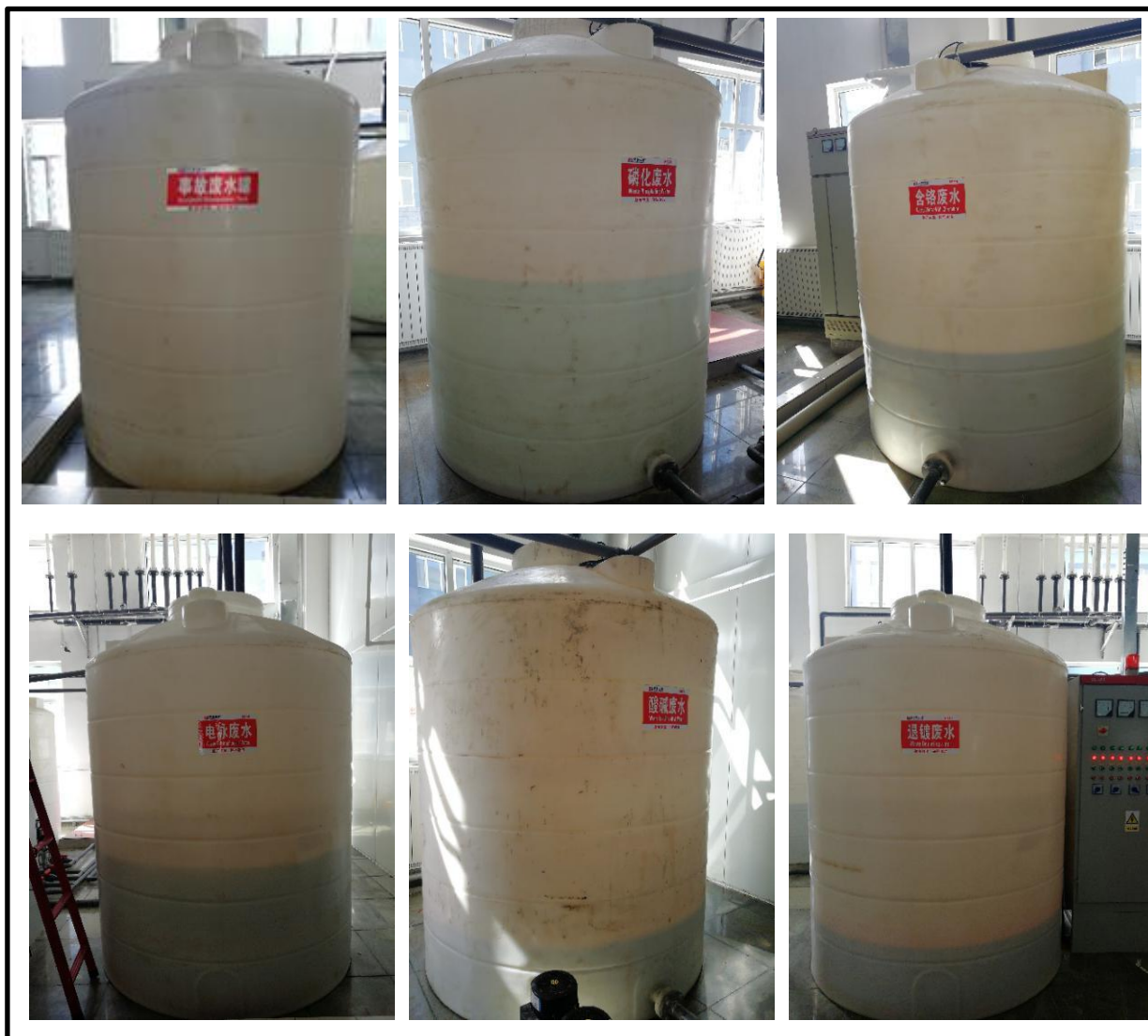
图 4-1 A2 厂房废水暂存罐
