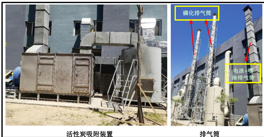
图 4-3 A2 厂房废气处理措施
