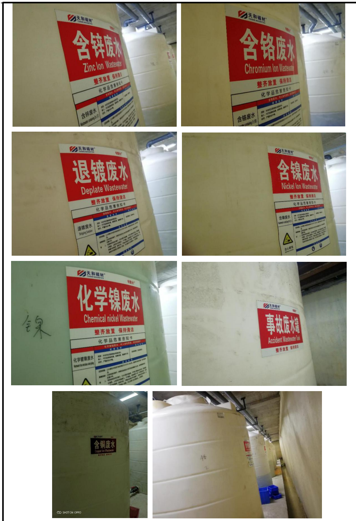
图 4-2 B3 厂房废水暂存罐
