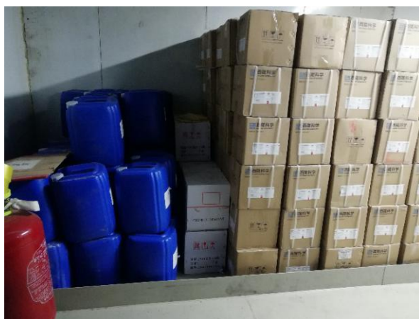
A2 液体化学品库设置的围堰
