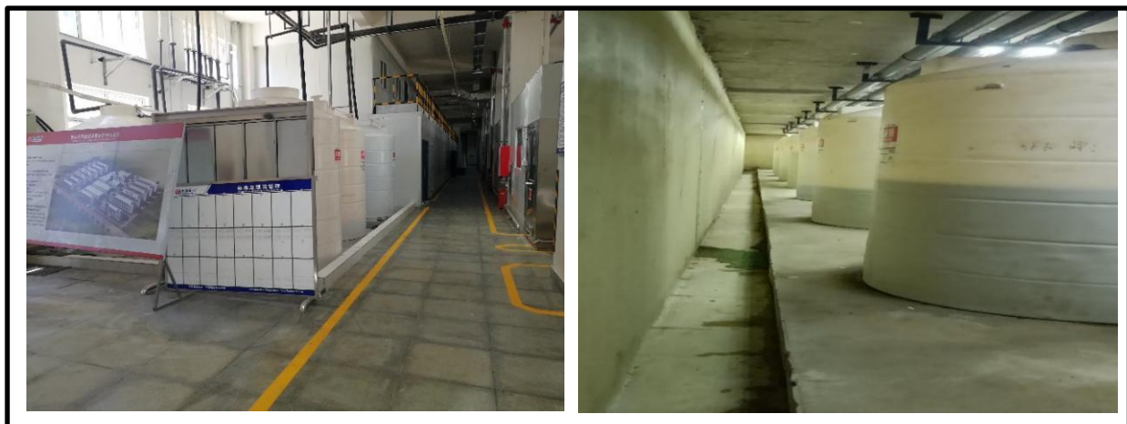
图 4-10 A2、B3 废水收集区防渗措施
